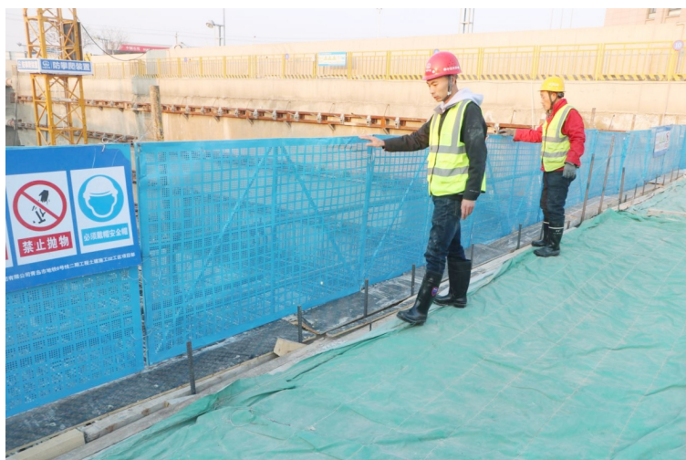
刘家宏(左)和父亲在地铁6号线二期施工现场检查临边防护。
