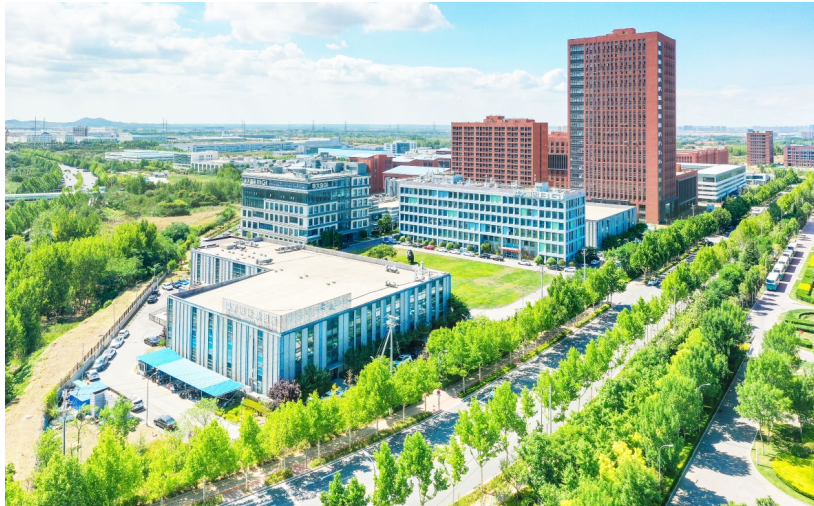
位于青岛自贸片区的青岛华大智造科技有限责任公司
