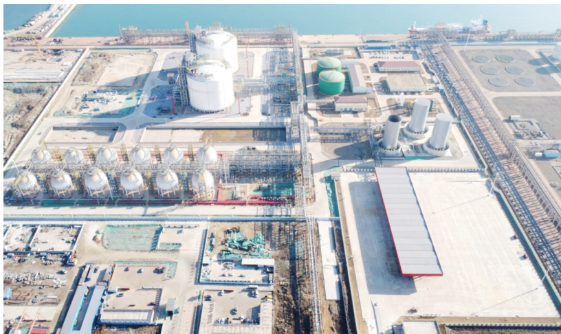
董家口港区液体化工仓储工程(二期)成新区今年首个竣工的港口工程项目。
