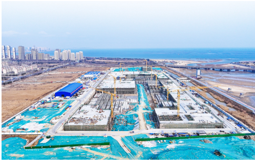
风河生态运动公园项目施工加速推进。
