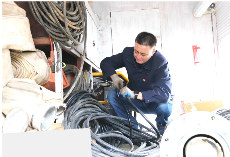
陈增辉正在检修供水设备零件。
