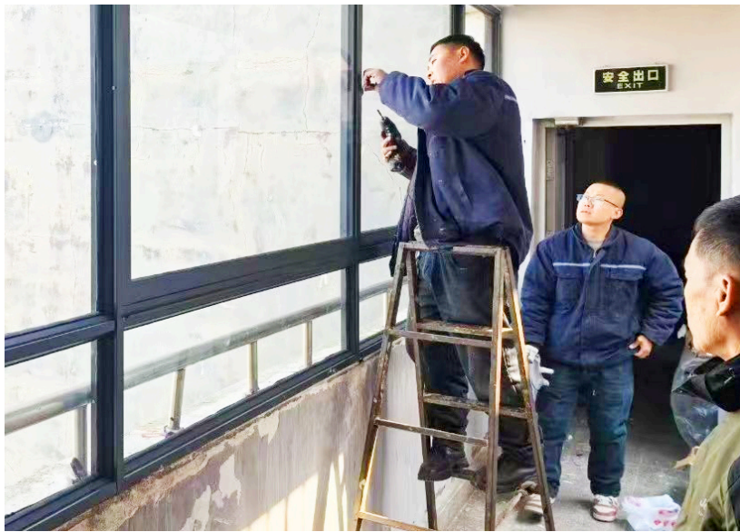
▲凤海苑小区物业人员对损坏的连廊玻璃进行更换。
