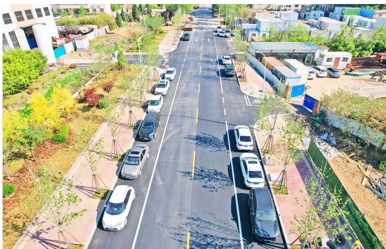
▲民和街南延工程（二期）项目完工通车。
