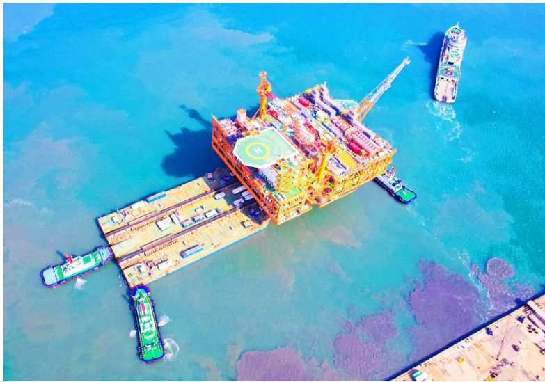
▲我国渤海最大海上油气平台在新区离港起运。
