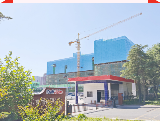
▲位于东辛庄社区的智能仓储物流项目顺利封顶。 □记者 梁玉鹏 摄
