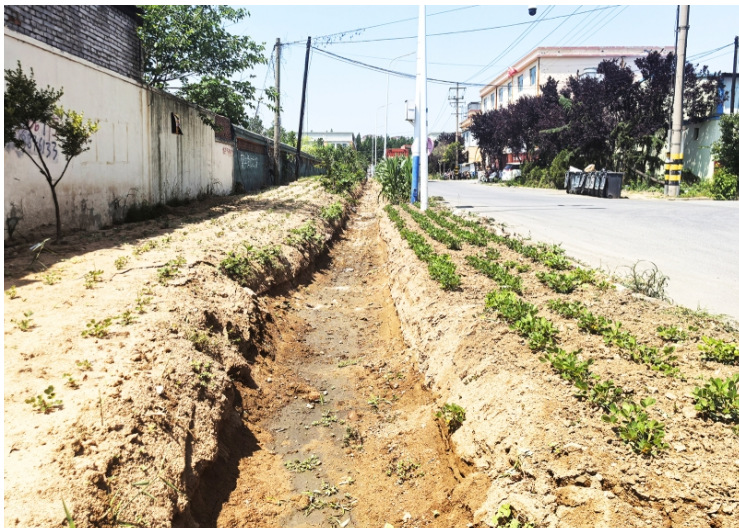
明渠，缓解汛期区域排水压力。 隐珠街道在台兴五路路南开挖
