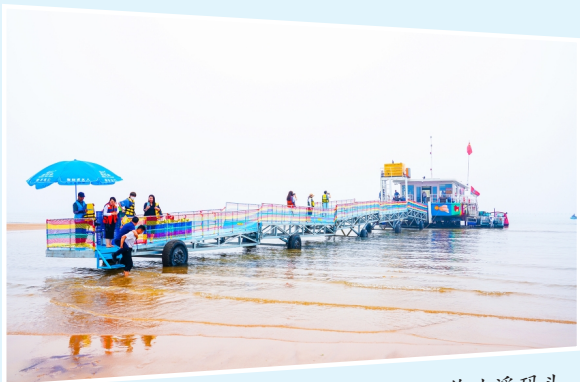
▲项目采用可移动式趸船作为浮码头。
