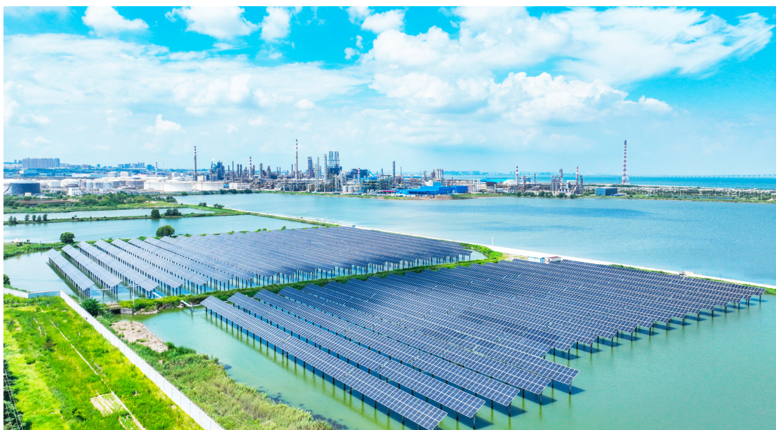
全国首座海水漂浮式光伏电站在青岛炼化投用。(青岛炼化供图)
