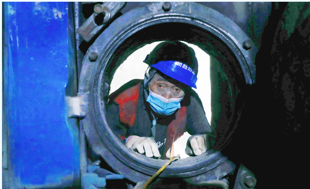
在锅炉浇筑料拆除现场，工人在狭小的空间内作业。
