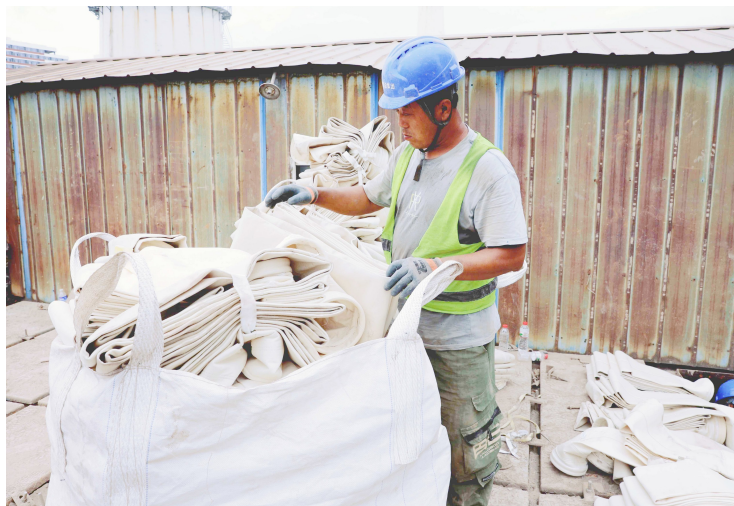
▲除尘器袋笼布袋拆除更换现场，工作人员清点新布袋。
