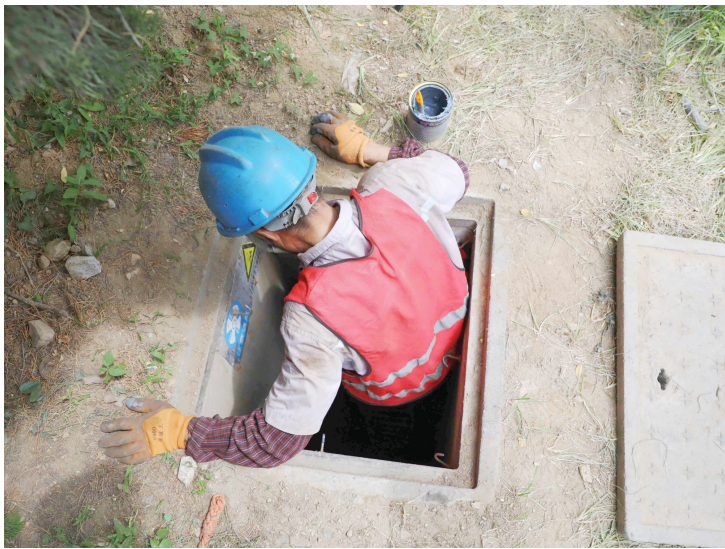
▲工作人员下管道井保养供热阀门。
