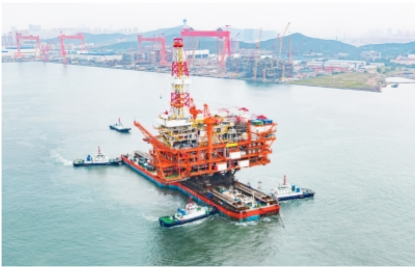
▲惠州25-8项目DPPB平台组块从新区起运。(海洋石油工程(青岛)有限公司供图)
