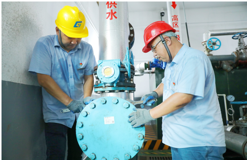
▲能源公司供热运营党员突击队队员正在检修设备。(公用集团供图)
