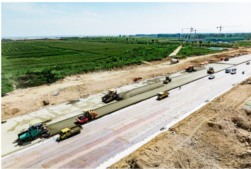
▲集成路工程(信阳东路至疏港二路段)(一期)施工加速推进。(董发集团供图)
