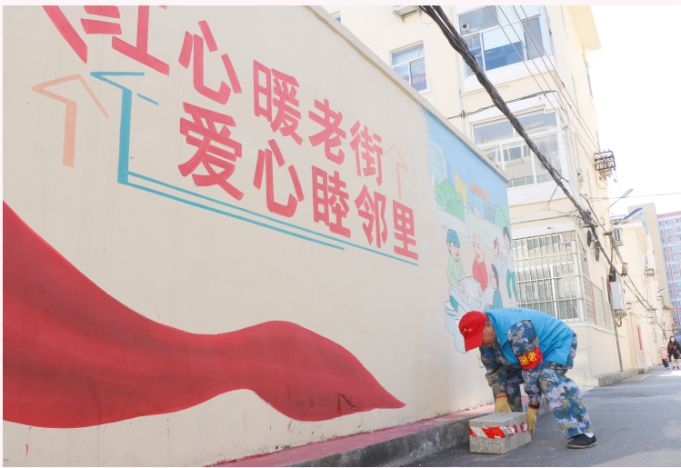
▲“面子”“里子”双提升，海化家属院小区焕新颜。
