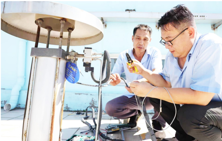
▲工作人员维修活性炭滤池排水阀。(水务公司供图)
